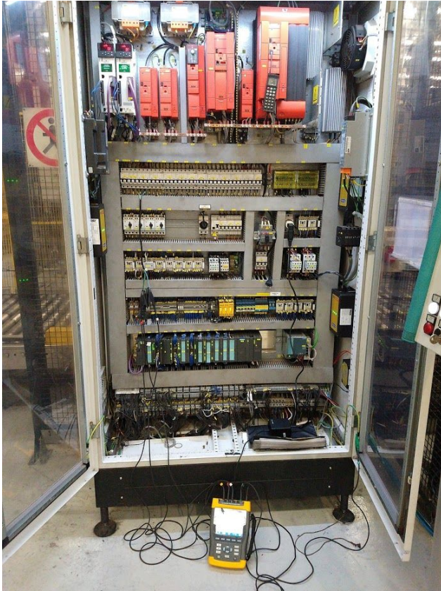
Figuras 1 e 2 - Exemplos de instalação do analisador de qualidade de energia.
