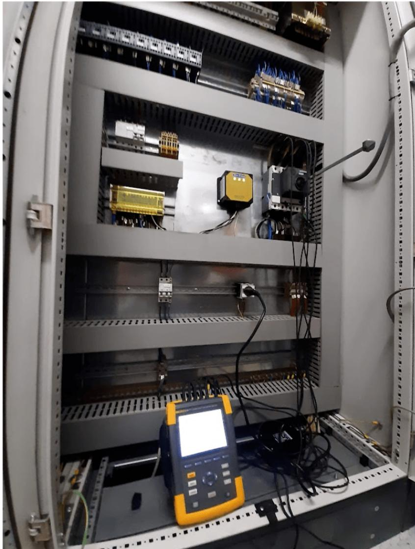
Foto de um supressor SineTamer instalado em um painel
