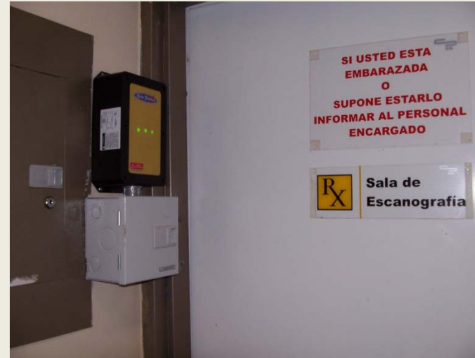
SUPRESOR LA ST60 3Y1C LABORATORIO DE ESCANOGRAFIA
