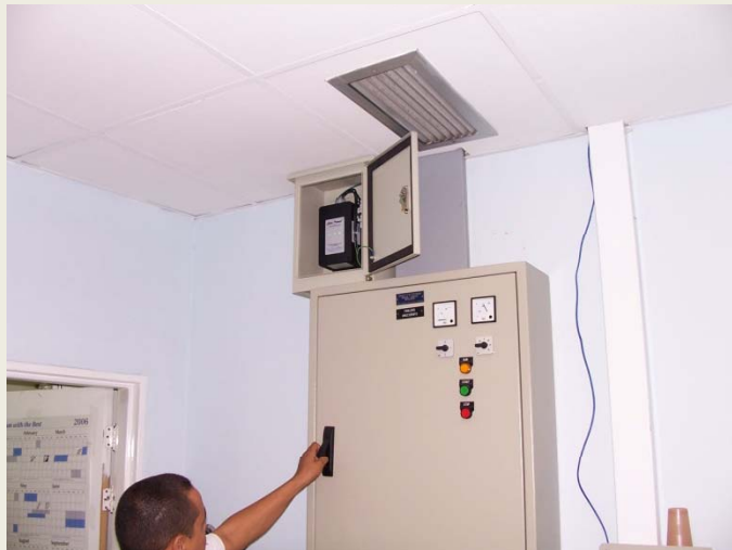
SUPRESOR LA ST60 3Y1C SALA DE ANGIOGRAFIA
