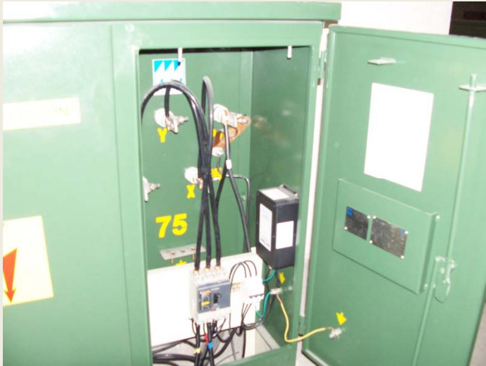
SUPRESOR LA ST120 3Y1C TABLERO - ANGIOGRAFIA
