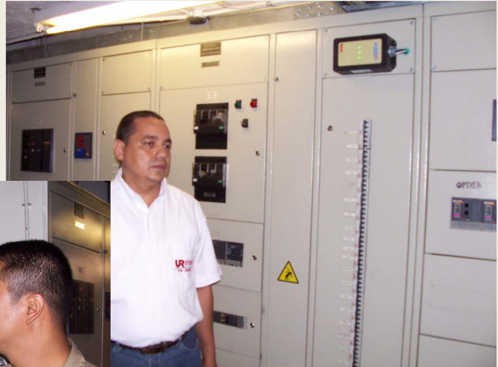
SUPRESOR LA ST240 3Y1C EN PANEL PRINCIPAL
